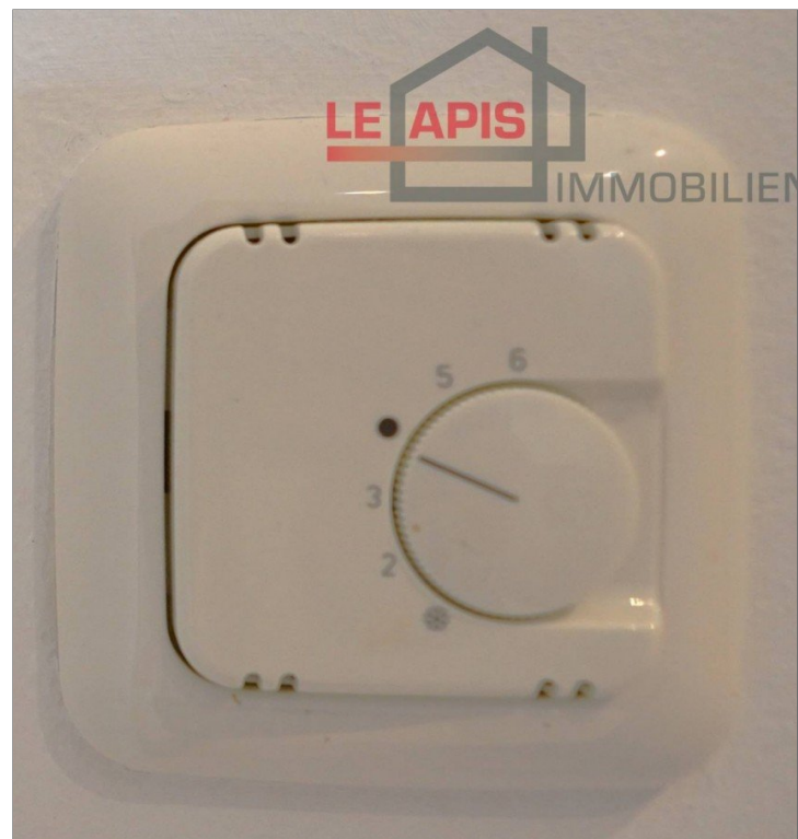
Heizungsregulator f. Fußbodenheizung
