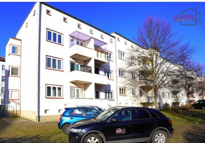
Hausansicht hinten Bild 2
