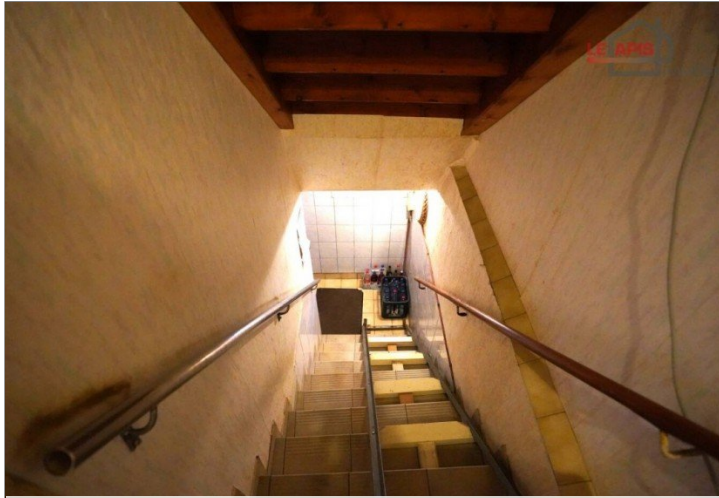
Treppe zum Kellerbereich
