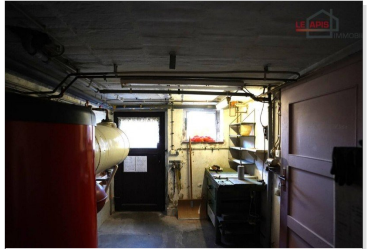
Heizungsraum m. Zugang zum Garten
