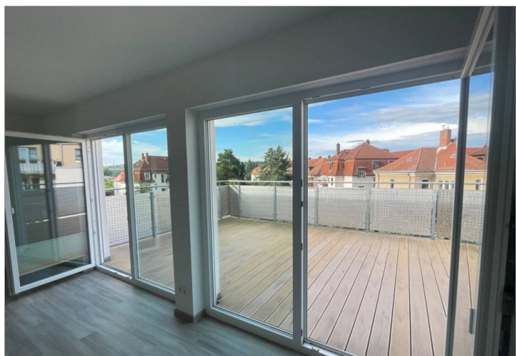
Zugang v. Wohnzimmer zur Dachterrasse
